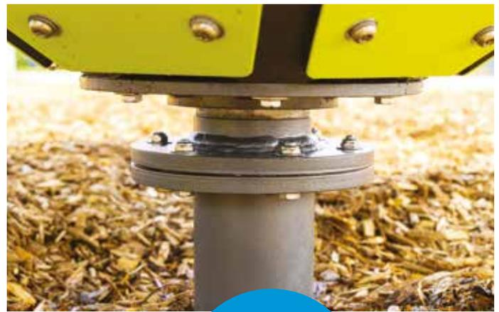
La plateforme est constituée de plaques de polyéthylène au fini antidérapant. Elle recouvre une structure d'aluminium et d'acier solide. Le mât central est en aluminium et possède une poignée en polyéthylène confortable. Le mouvement de rotation est rendu possible grâce à deux roulements de qualité industrielle, un à billes et un autre à rouleaux.
